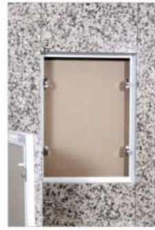
SERAMİK YAPILMAYA BAŞLAMADAN ÖNCE KAPAĞIN SERAMİĞİ YAPILIR KURUDUKTAN SONRA YERİNE TAKILIR. CERAMIC OF COVER IS TILES BEFORE CERAMIC TILING. MOUNTED TO ITS LOCATION AFTER DRYING.
